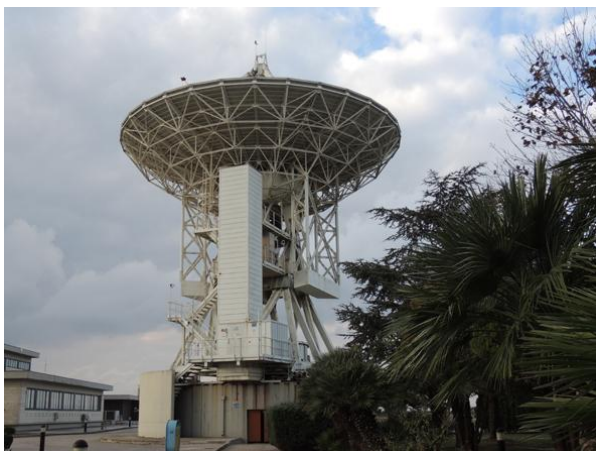
Una delle antenne paraboliche del Centro di Geodesia Spaziale di Matera che ricevono il segnale delle quasar
