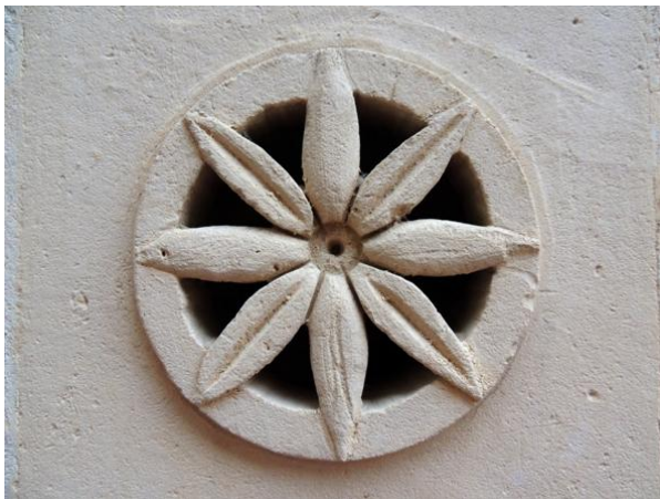
Una presa di aerazione scolpita nella calcarenite con cui sono fatti gli edifici dei Sassi
